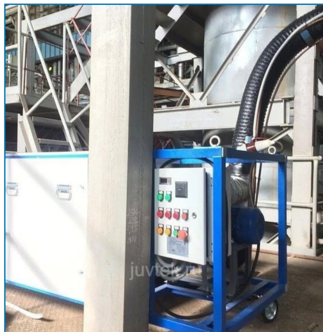
Рисунок 3. Установка для консервации паровой турбины 60 МВт, смонтированная на Новгородской ТЭЦ.
